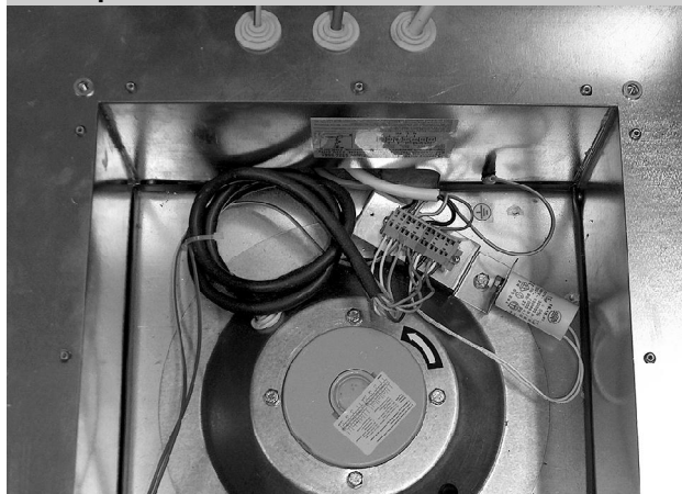
23. kép – belső elektromos bekötés
